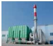
I processi biologici iniziano dopo qualche ora di permanenza nelle biocelle. Il calore, generato dalla decomposizione microbica delle sostanze organiche, contribuisce a far evaporare l'acqua contenuta nelle sostanze. Il materiale diventa biologicamente stabile, perde fino al 30% di peso e aumenta il valore calorifico di circa il 35%.
